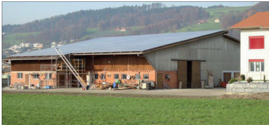
Die PV-Anlage auf dem «Falkenhof» Wauwil hat bereits im ersten Betriebsjahr ihre kalkulierte Stromerzeugung übertroffen.
