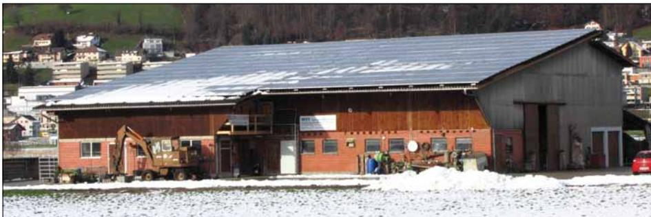
Auf dem «Falkenhof» (an Strasse Wauwil-Ettiswil gelegen) wurden 350 PV-Module (550 m<sup>2</sup> Fläche) installiert. Ab Mitte Dezember 2012 ist diese Photovoltaik-Anlage in Betrieb. Sie wird schätzungsweise den jährlichen Strombedarf von 15 – 20 Privathaushalten erzeugen.
