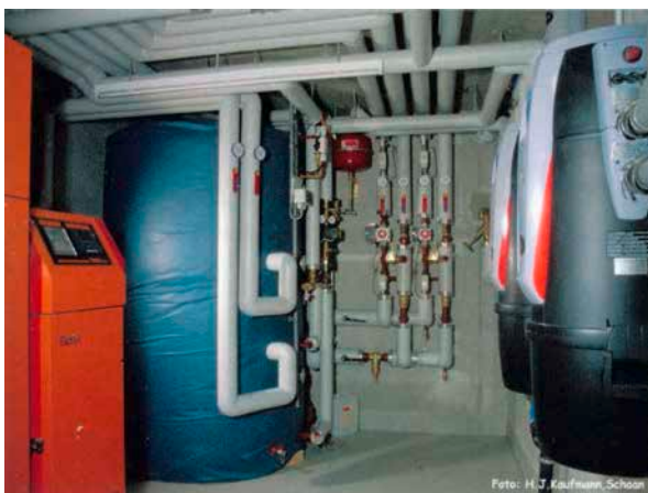
Solarunterstützte Pellet-Heizanlage
