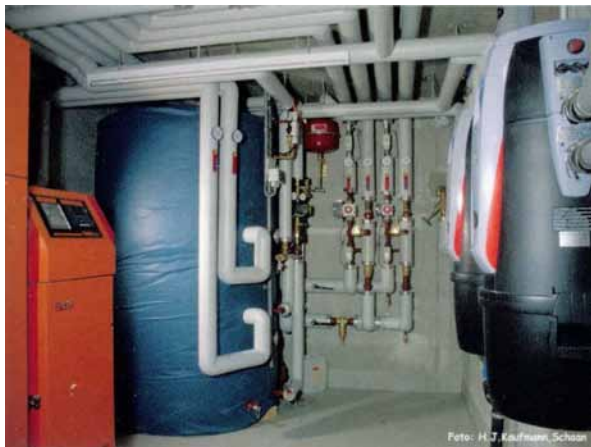
Solarunterstützte Pellet-Heizanlage
