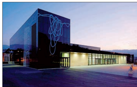
AEGERIHALLE, modernste Architektur in Unterägeri
